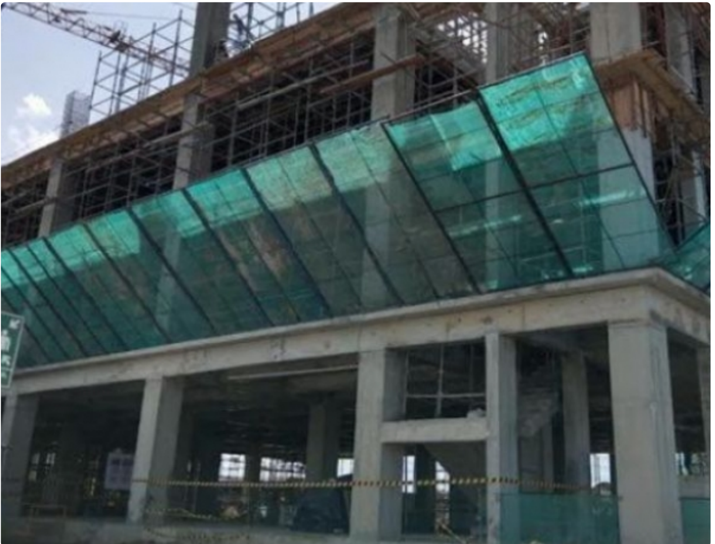
Gedung baru RSUD dr Soedomo dalam pembangunan
